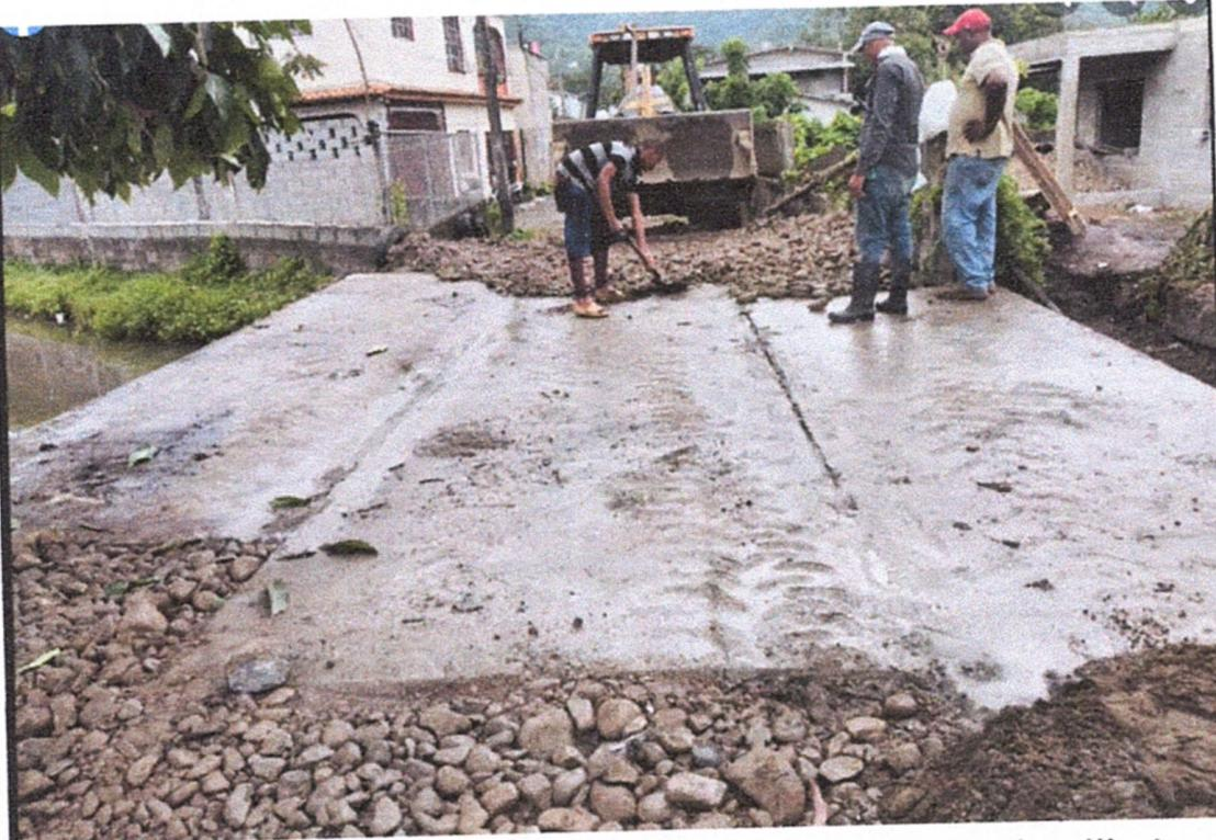
Así está quedando la construcción del Puente en la Calle de los Custodio detrás de la Ferretería Hermanos Díaz, con la construcción de dicho puente estamos solucionado una problemática que afectaba a los moradores de esta comunidad, ya que cuando llovía las alcantarillas que tenía no podían con la gran cantidad de agua y las mismas se tapaban y se devoraba el canal por esta razón se inundaban todas las viviendas de esa
