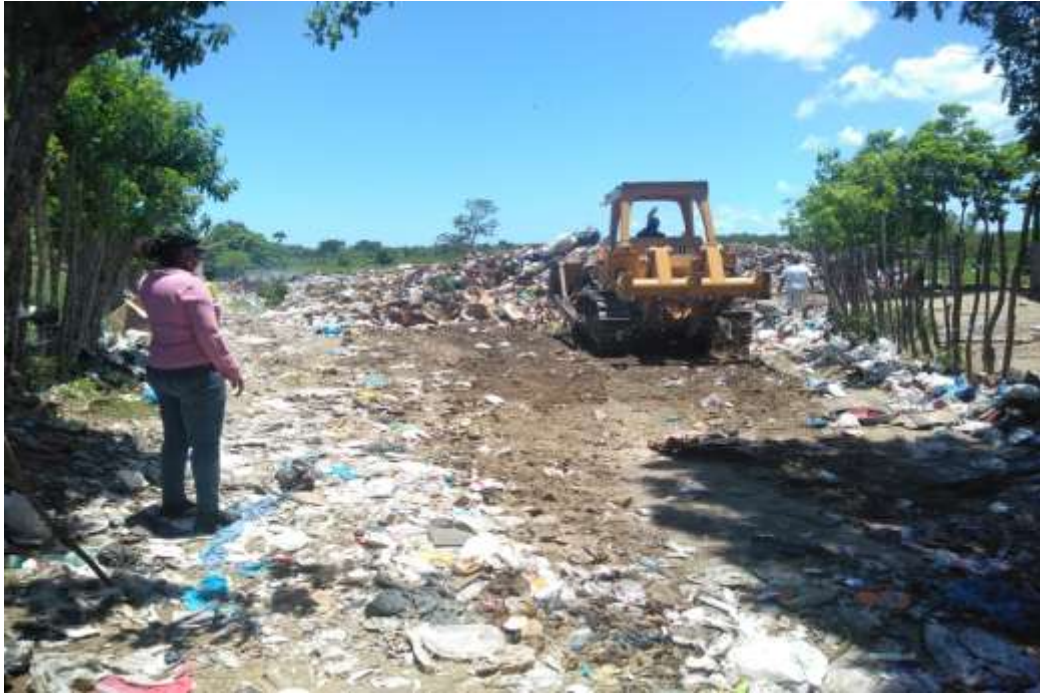
Proceso de apilamiento de residuos con buldócer en el Vertedero de Veragua.
