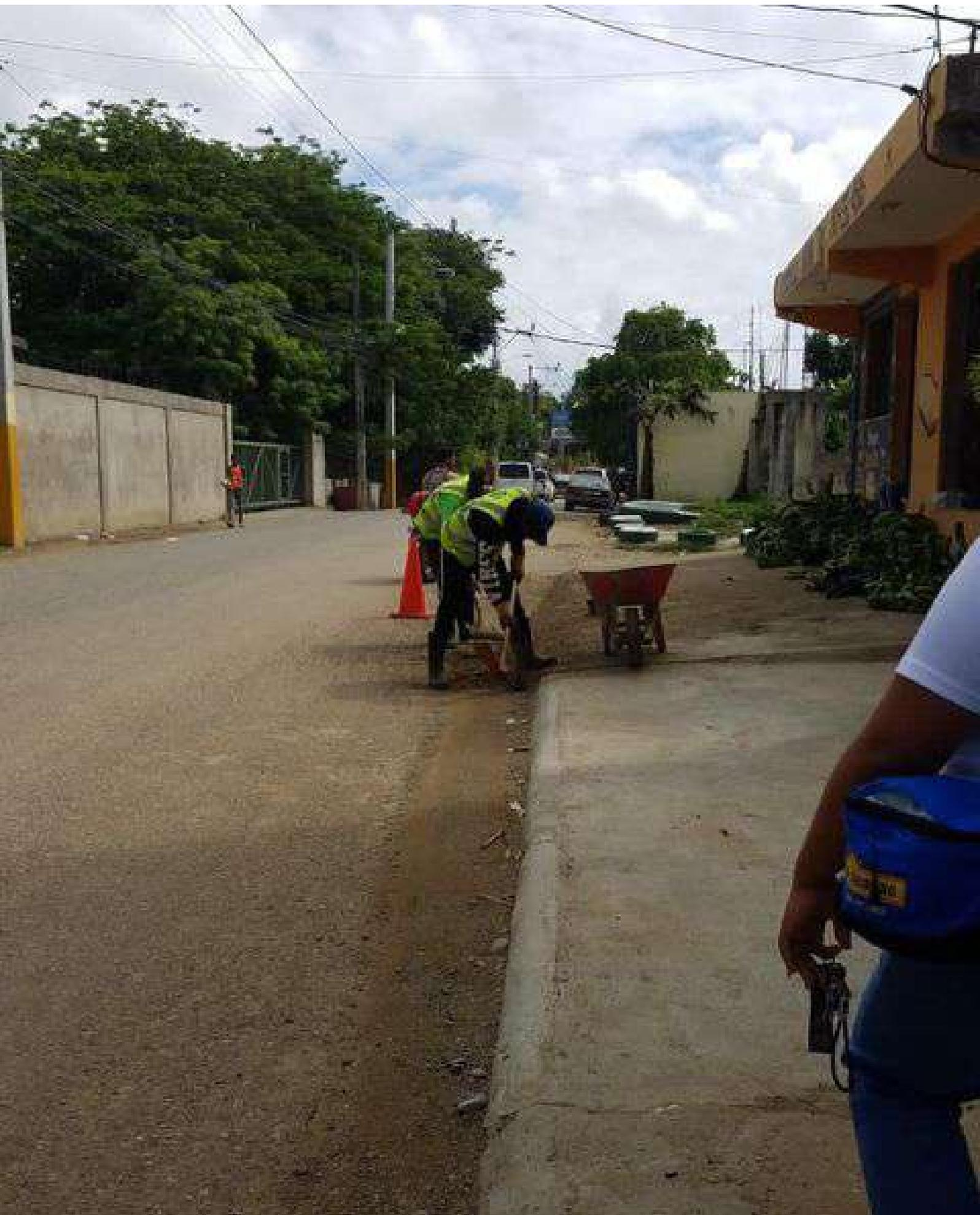
La CAASD, después de la colocación de las tuberías, está realizando la prueba de rigor antes de colocar el material para el relleno de la tosca. Estamos trabajando en el Sector de los Coquitos 3ero.
