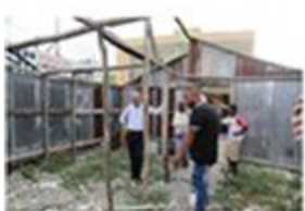
Llegan las reparaciones de viviendas al Maní abajo.
