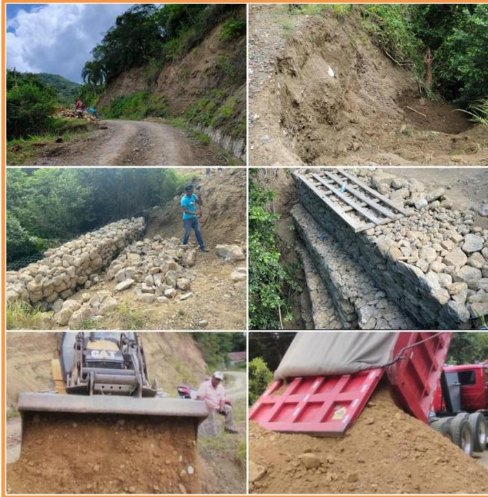
Después de observar la problemática de la carretera que une la comunidad de Higo de Agua con Pérez Arriba, la Junta de Vocales se reunió para priorizar la solución al derrumbe próximo al arroyo de esa comunidad. Para resolver tal mal se construye un muro en gavión de piedra y relleno compactado.
