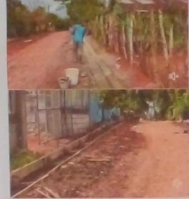
Trabajando los contenes en el barrio Las Flores
