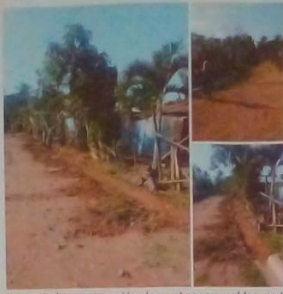
Inicio de la construcción de contenes en el barrio Las Flores.
