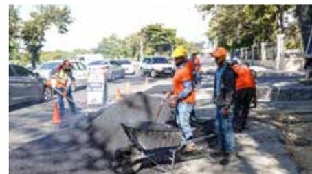
En este operativo de bacheo se utilizaron unos 4,720mt<sup>2</sup> de material asfáltico, que será colocado inmediatamente después de la extracción del material inservible, hasta dejar los puntos críticos completamente tapados.
