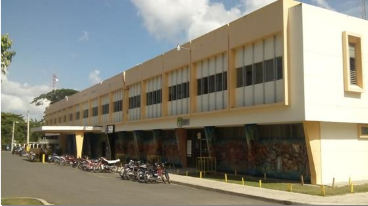
Edificio De Oficinas Públicas Municipio de Salcedo.
