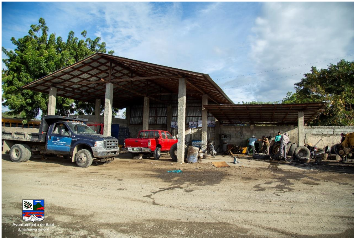
Foto 3. Talle de herrería, electricista y gomeros
