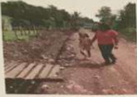
INDICACIONES LA TERMINA DEL SECTOR GUAYABITO
