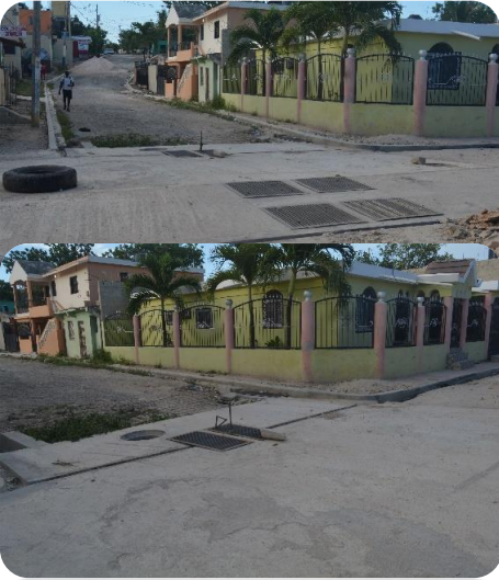
COLECTOR PLUVIAL DE SAN CARLOS Y PARRILLA
