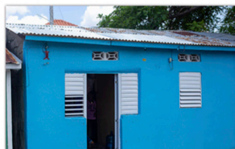
Reparación de viviendas Los Cajulitos
