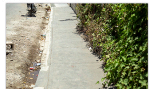
Aceras y contenes Sabanita
