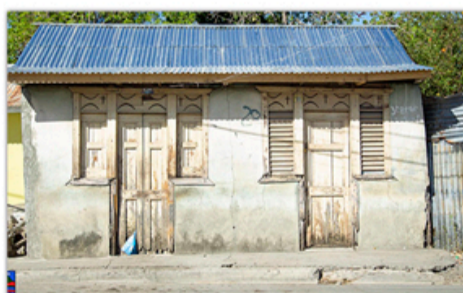
Reparación de viviendas Los Tendales
