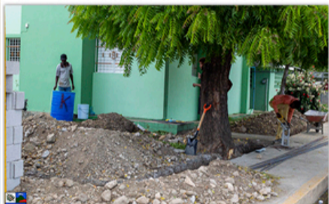
Verja perimetral Apto. Escondido
