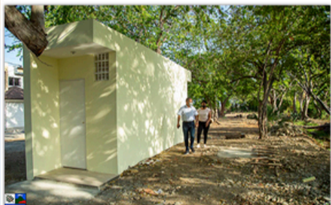
Continuación de baños Urb. Palo Blanco
