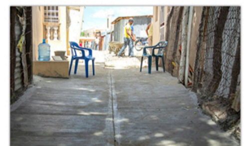
Hormigonado Callejón "Don Isidro"
