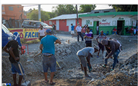
Reparación baden c/Canela Mota con Canal Marcos A. Cabral.
