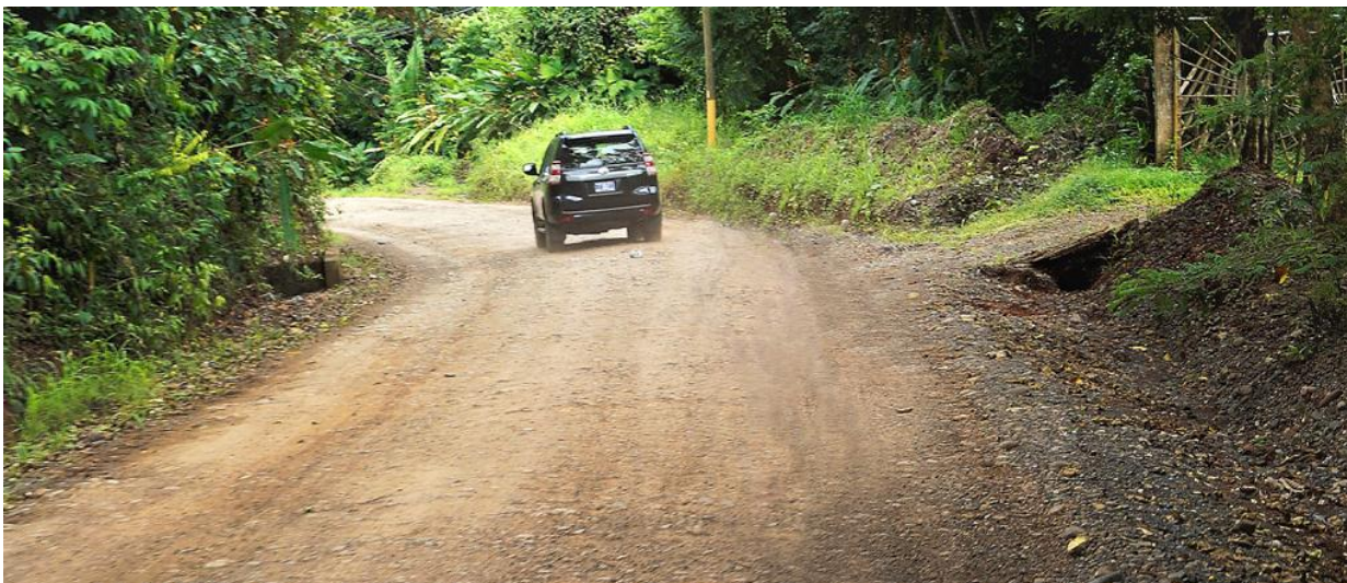
Calle sin asfaltado
