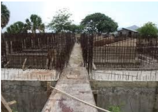
Construcción Planta de Agua Potable de Partido
