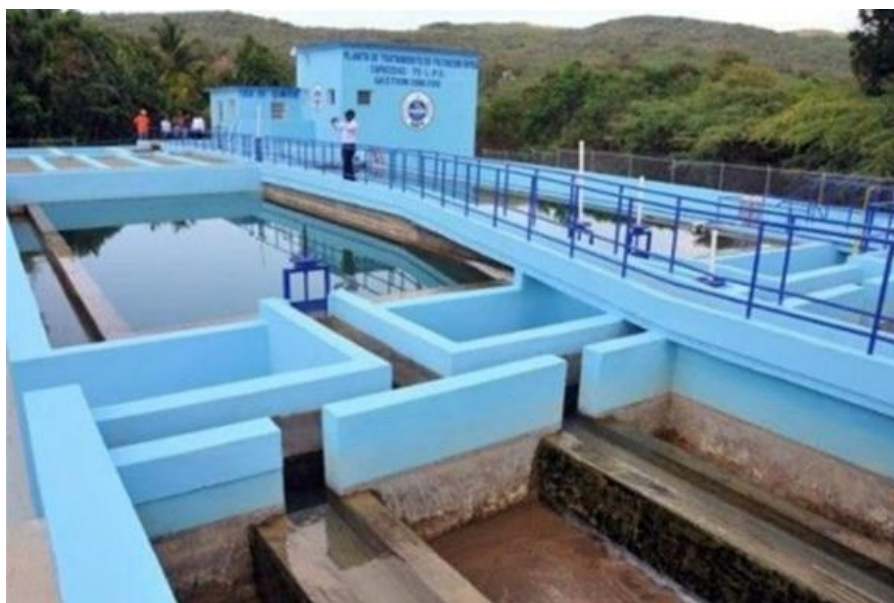
Planta de agua potable en Loma de Cabrera
