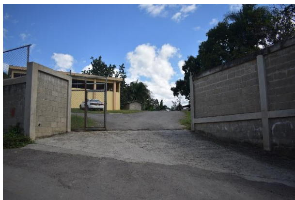
Matadero Municipal de Loma de Cabrera
