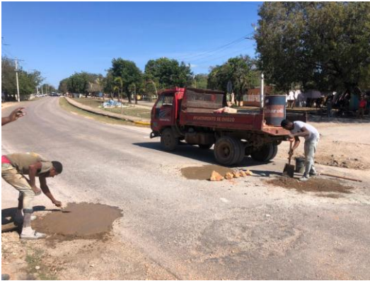
Reparación de deterioro en la vía principal Oviedo, Pedernales.
