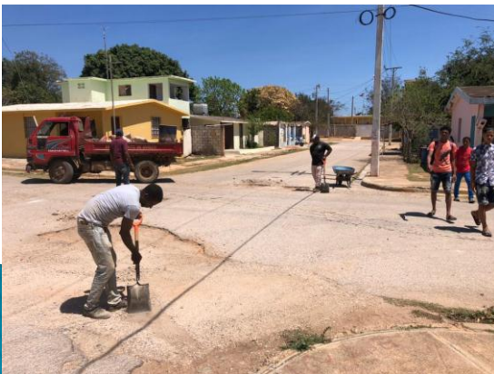
Reparación de deterioro Calle Eugenio María de Hostos
