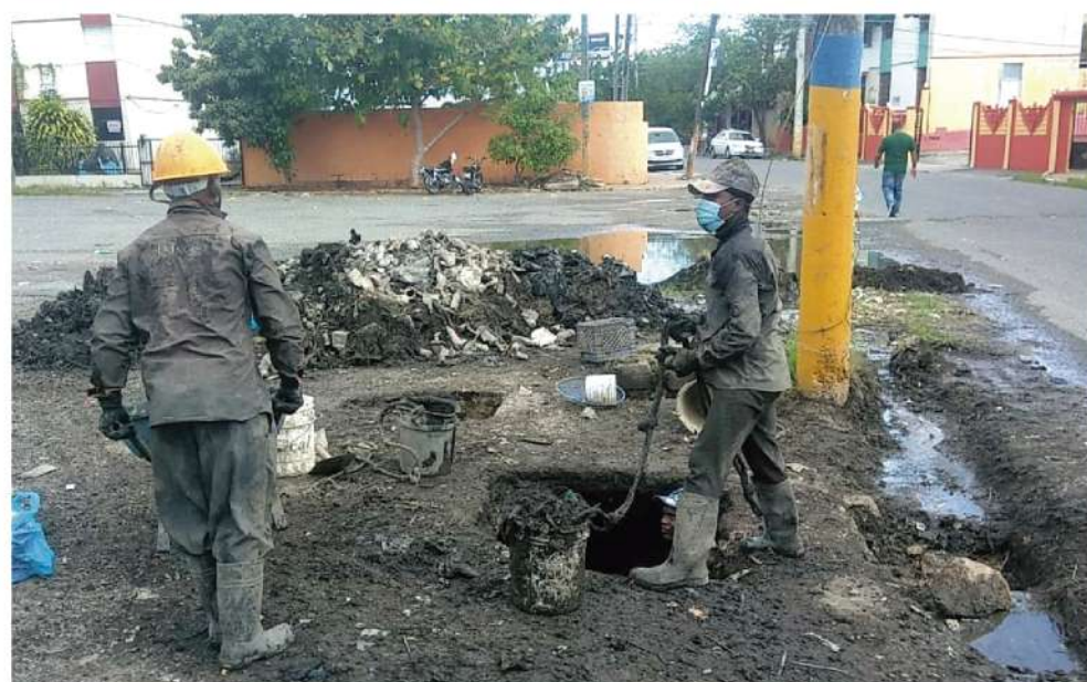
Momento en que obreros limpian pozo filtrante.
