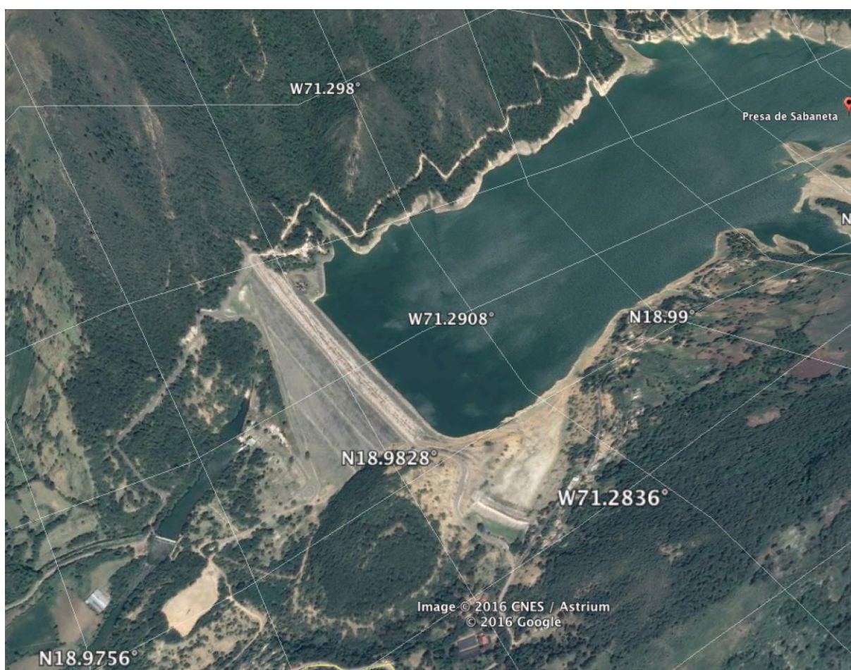
Fig. 6 presa de Sabaneta (Fuente Google Earth)
