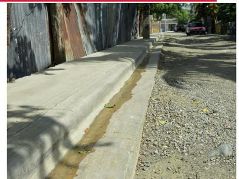
Mientras que en la Ciudad Don León, La Barranquita, se realizaron 1,262.50 metros lineales de contenes, se construyeron dos badenes nuevos y se repararon dos existentes que estaban deteriorados, además se realizó un relleno y perfilado para la nivelación de las calles intervenidas.
