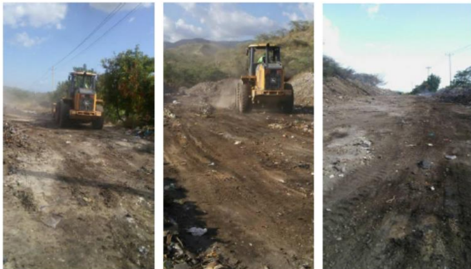
Fig. 13. Vertedero de Villa Jaragua en mantenimiento.
