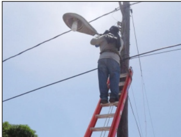
Reparación de lámparas en las avenidas principales
