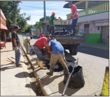
Bacheo con asfalto en la zona centro del municipio
