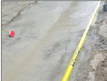
Construcción badén entrada Joya Light
