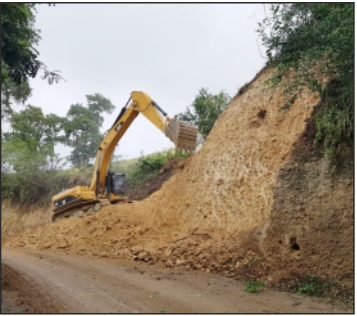
Corte de montaña en Terrero para alejamiento del tránsito por derrumbe
