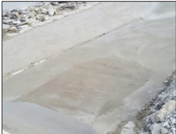
Construcción badén sector Villa Estabania
