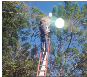
Reparación de luces cancha la zanja
