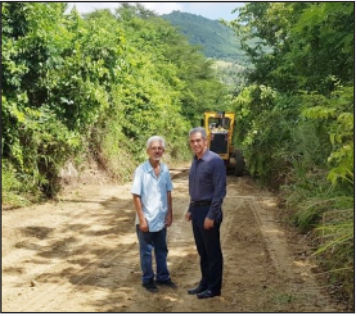
Acondicionamiento carretera Sabana Iglesia Janico por Gurabo
