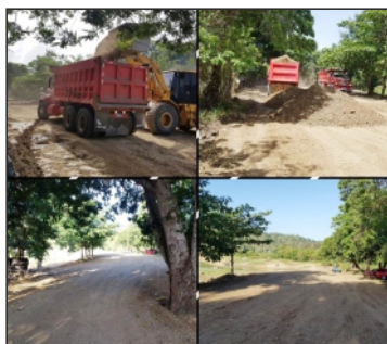
Acondicionamiento a entrada Presa Río Bao
