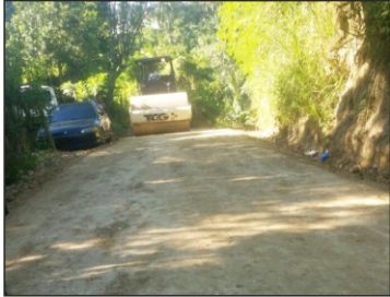
Acondicionamiento calle Hoya del Rincón
