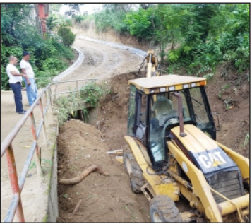
Trabajos de redirección de cañada para ampliación de puente detrás del cementerio
