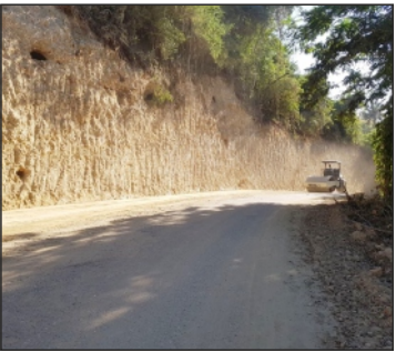
Acondicionamiento ampliación calle Terrero
