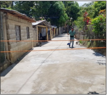
Pavimentación con cemento calle en el sector San Pedro con el apoyo de comunitarios
