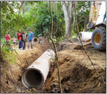
Colocación de alcantarillado en la comunidad de Hoya Rincón
