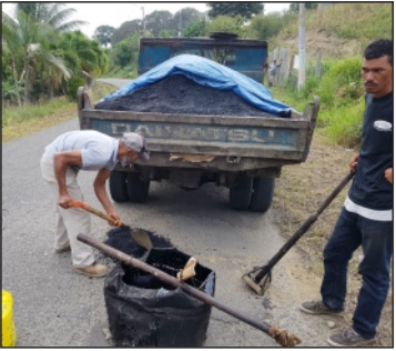
Bacheo con asfalto en el tramo de carretera Zalaya- Sabana Iglesia
