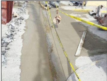
Construcción badén entrada Barrio Lindo
