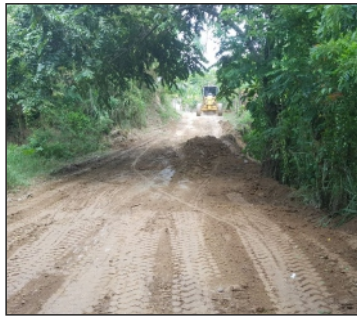
Acondicionamiento de caminos vecinales en la comunidad de Boca de Bao
