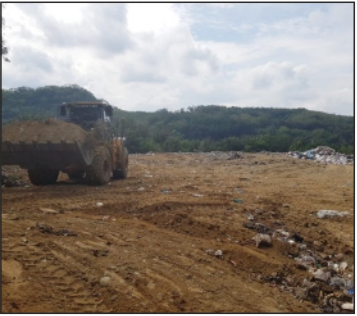
Acondicionamiento con maquinarias pesada del vertedero municipal
