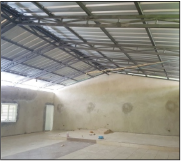
Aporte para techado capilla de la Galeta
