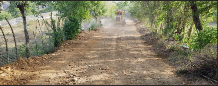
Arreglo con material de mina de la entrada a la presa de Bao por Palo Amarillo
