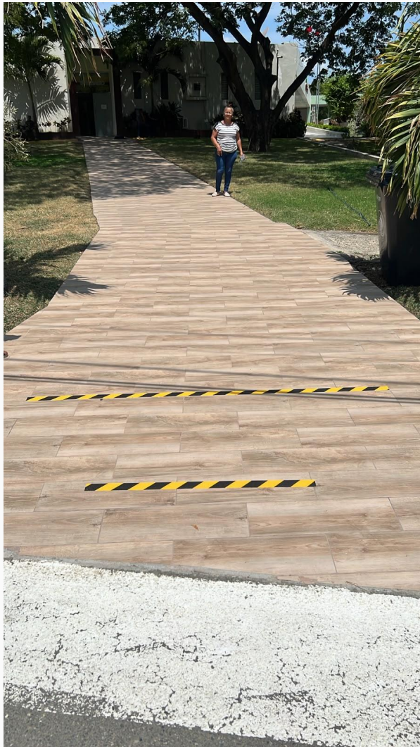
Evidencia 7: Colocación de señalizaciones en rutas de evacuación e instalaciones.
