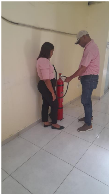
Figura 2: Mayelin (Mallelin María Collado) y José Gutiérrez realizando la inspección técnica física de extintores en las instalaciones de INTABACO (Junio 2026).
