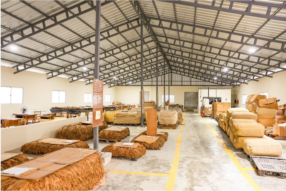
Área interna de la Nave Industrial
