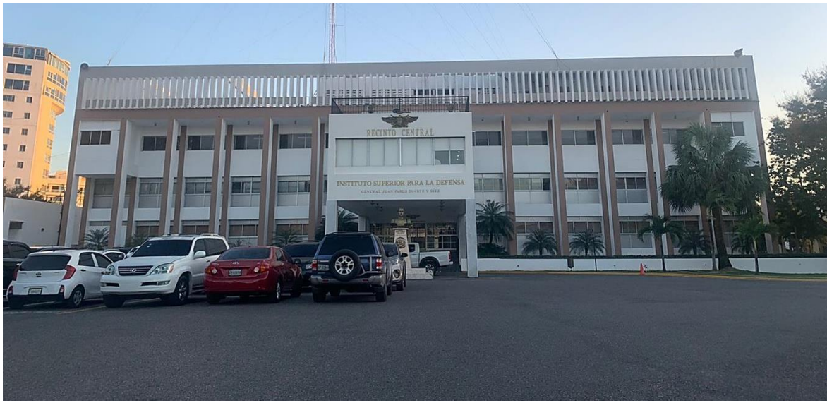
Edificio del INSUDE (Excepto en caso de sismo)
