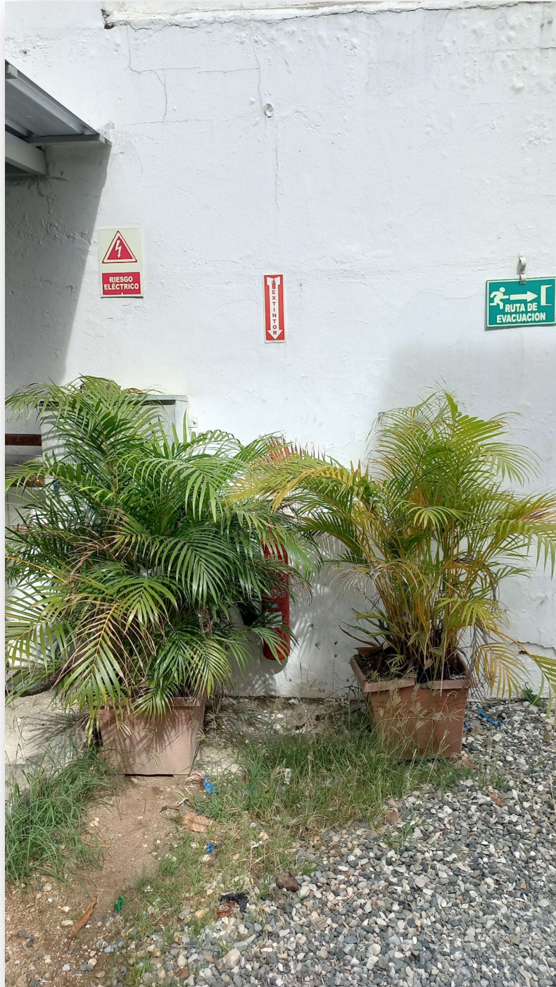
Extintor 674818 Patio, frente a la planta eléctrica.
