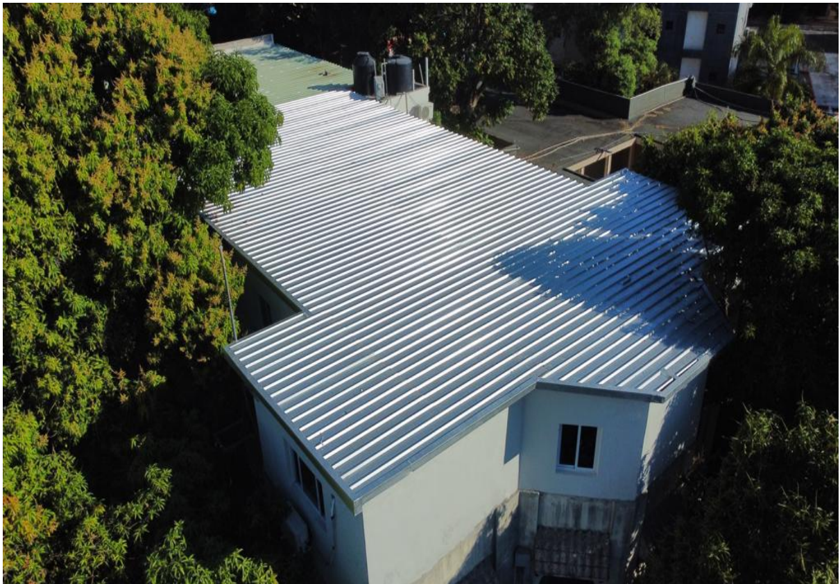
TECHADO EN LAS OFICINAS DEL TERCER NIVEL
