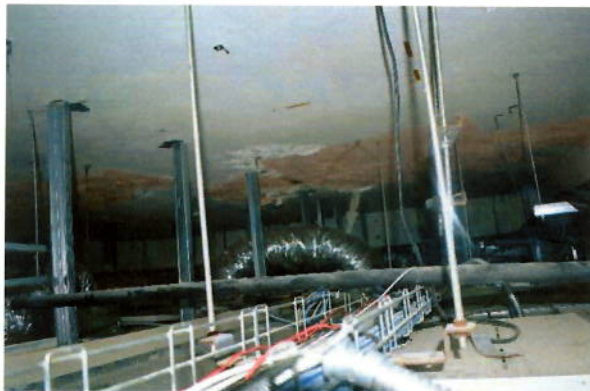
4. Corrosión en elementos de estructura anexa.
