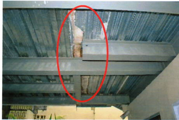
4. Corrosión en elementos de estructura anexa.
