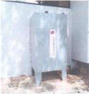
4. No tiene dique de contención el tanque de gas oil.
