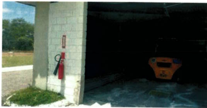
19) Instalación de Extintores y letreros en la PTPA Acueducto Línea Noroeste (ALINO)
