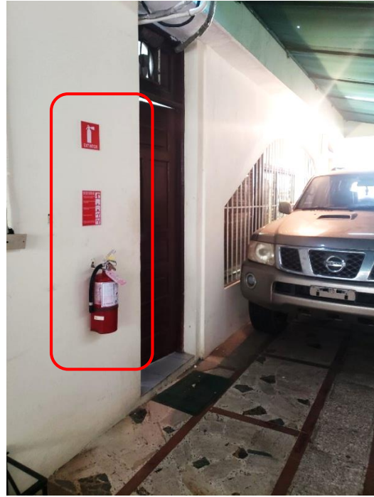
Ubicación: Exterior. Baño visitantes y parqueo vehículos oficiales.
