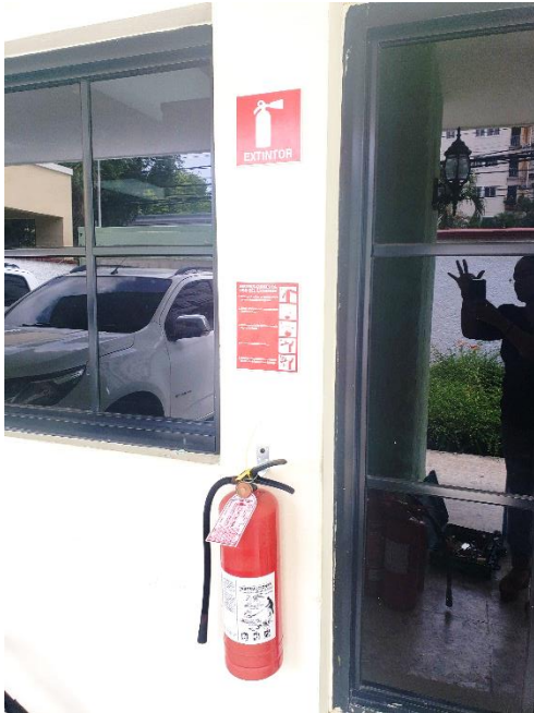
Ubicación: Exterior. Frente del edificio principal, entre la puerta de Recepción y Parqueo de vehículos oficiales.
