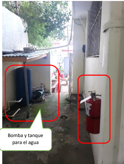
Ubicación: Exterior. Lado derecho del edificio principal, con puertas en frente y en el patio.
