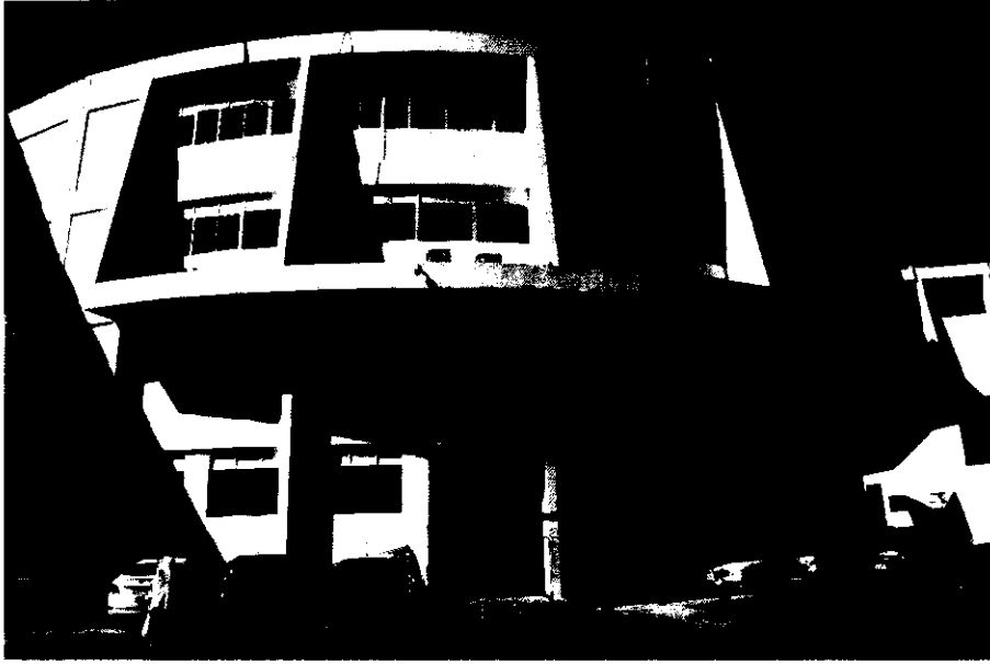
Imagen 6, Irregularidad por posible efecto de columna corta.
