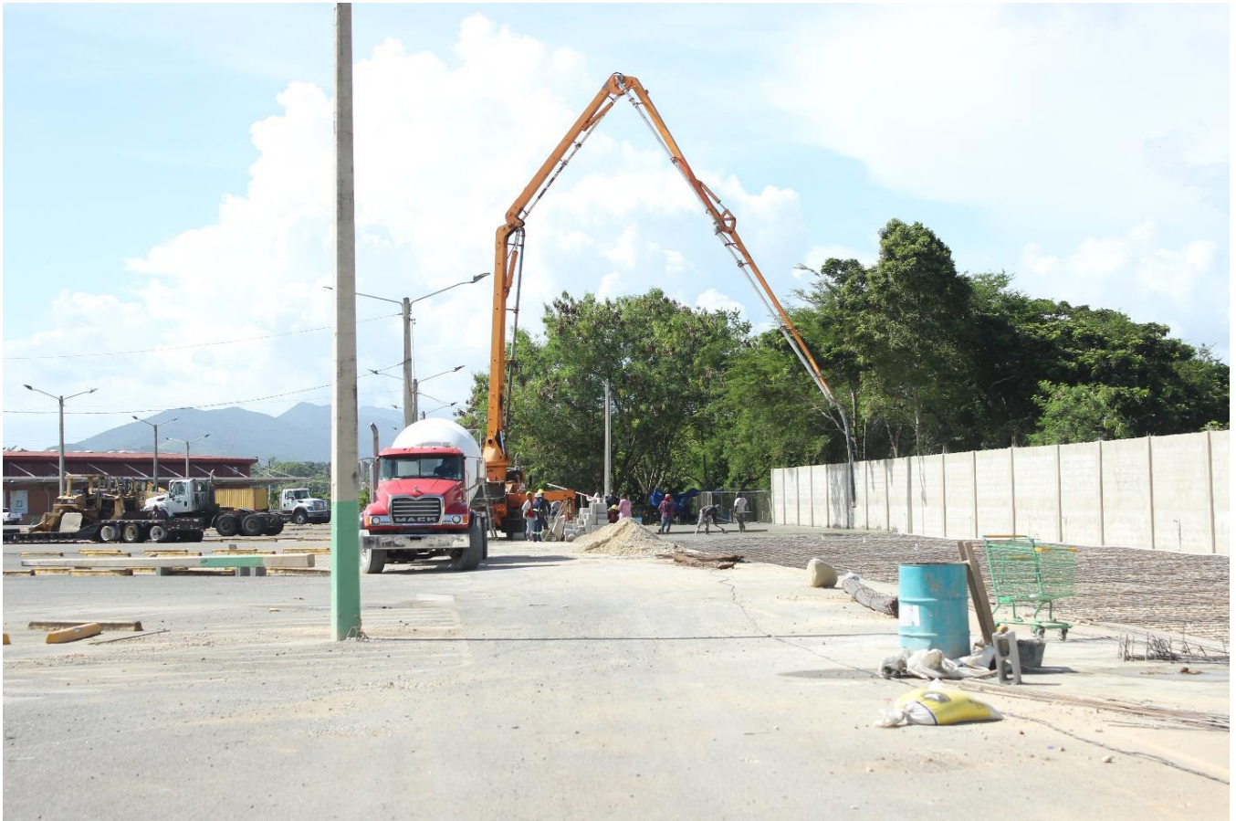
En la foto se muestra ejecución del proyecto de parqueo para camiones en el mercado.
