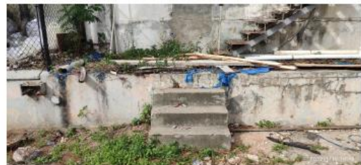
Terminación de la escalera de escape con escombros
