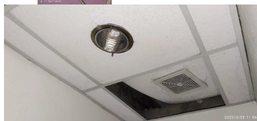
Partes del techo deterioradas
