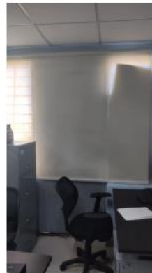
Puerta de emergencia obstruida
