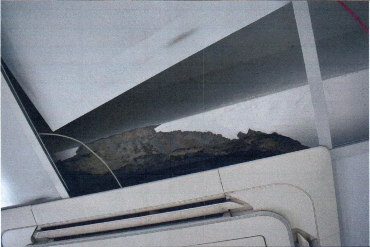
Muro de hormigon cortado, para ampliar espacio.
