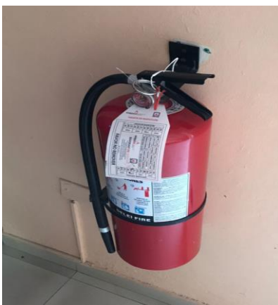
Instalación soporte para extintor
