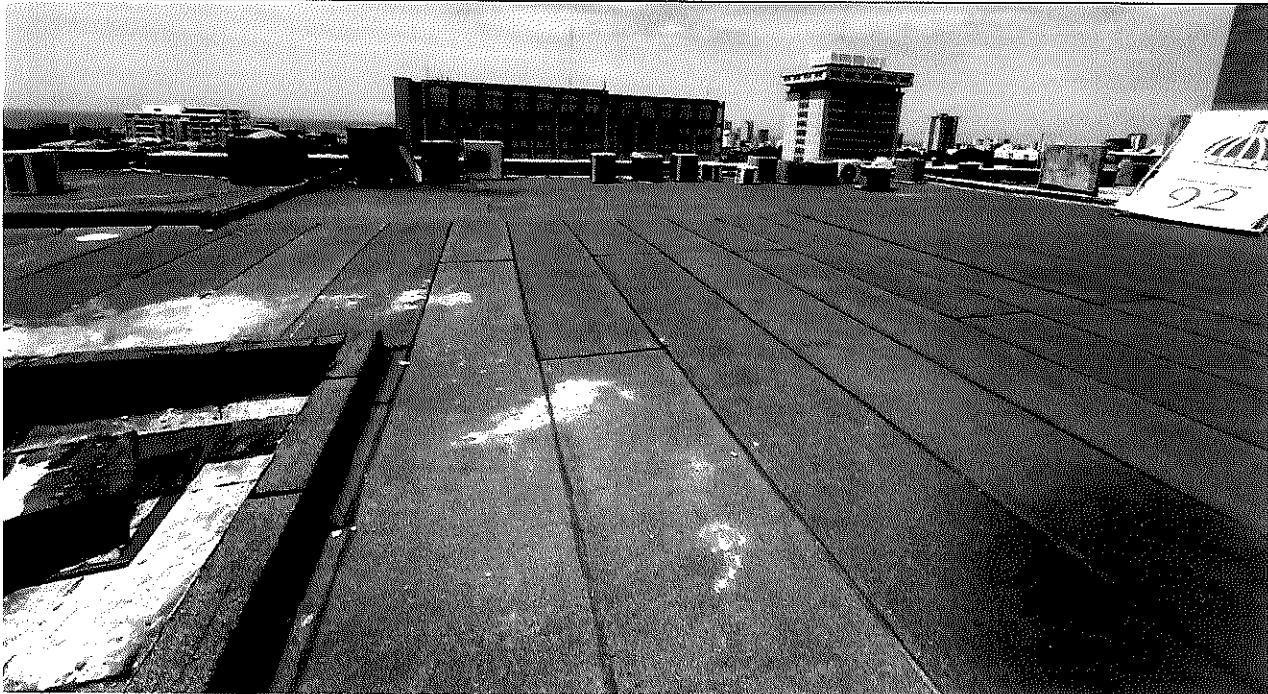
Foto 6. Techo del edificio en concreto
