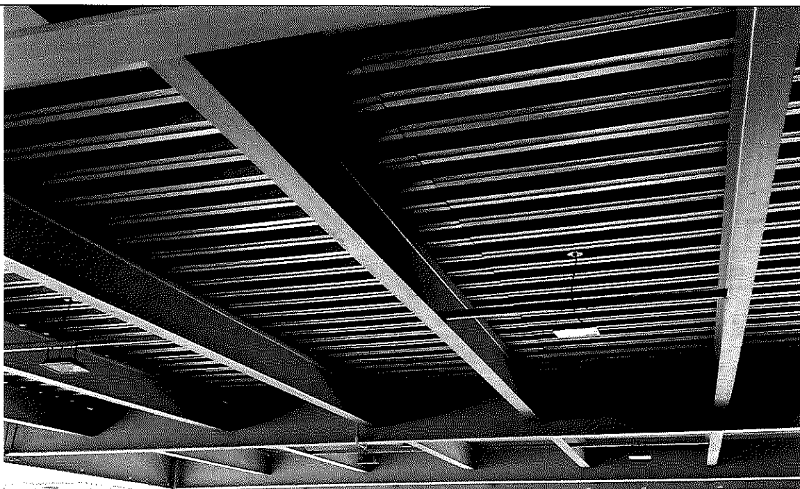
Foto 3. Sistema de Vigas del anexo en acero
