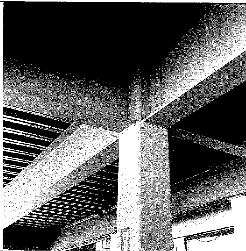
Foto 4. Columnas de acero tubulares
