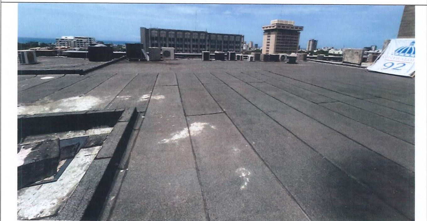
Foto 6. Techo del edificio en concreto
