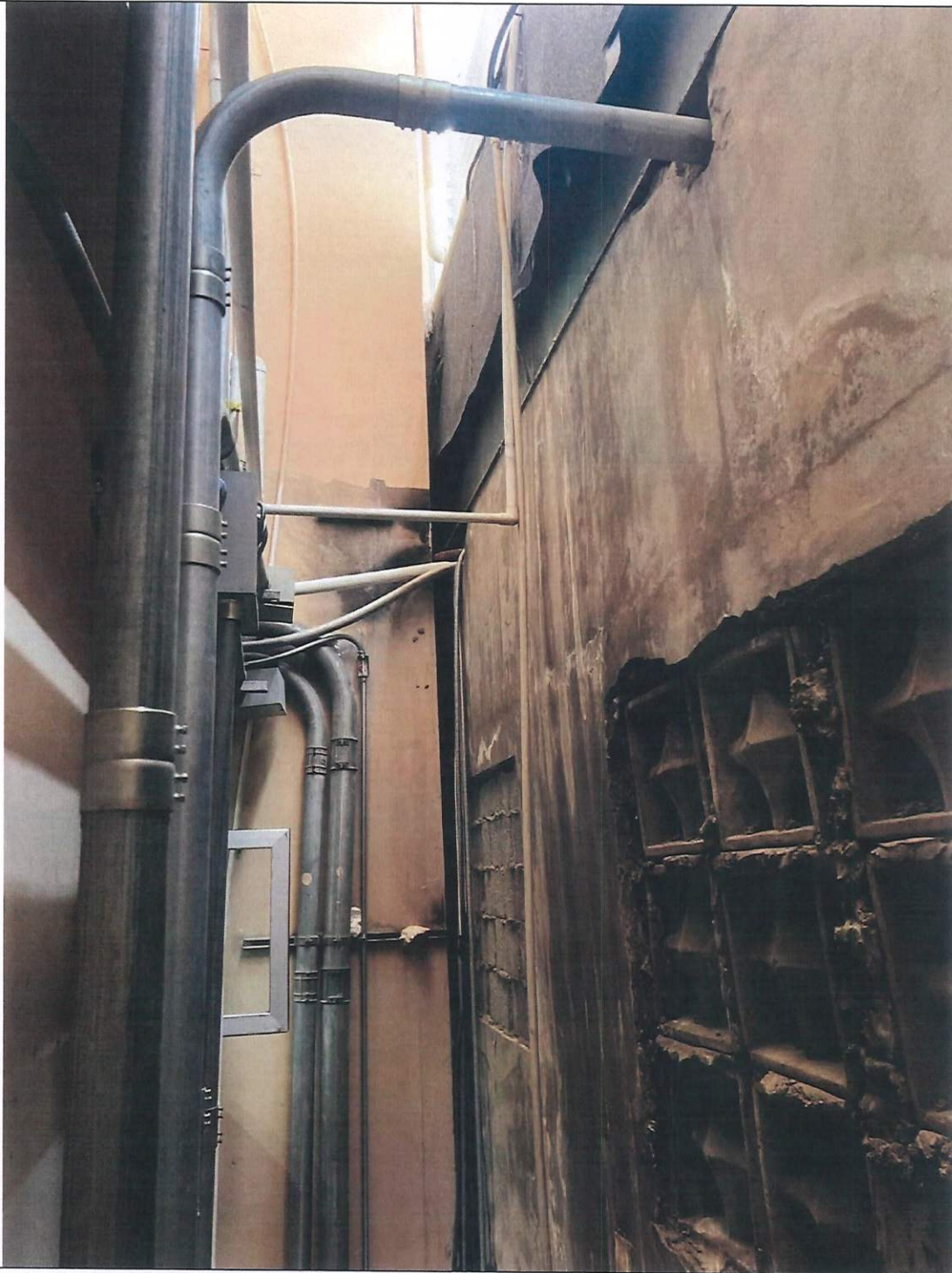
Foto 2. División entre edificio en concreto y anexo en acero
