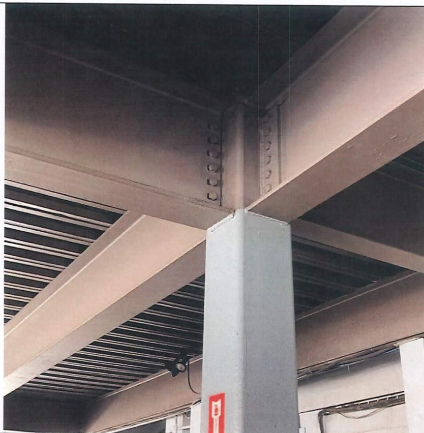
Foto 4. Columnas de acero tubulares
