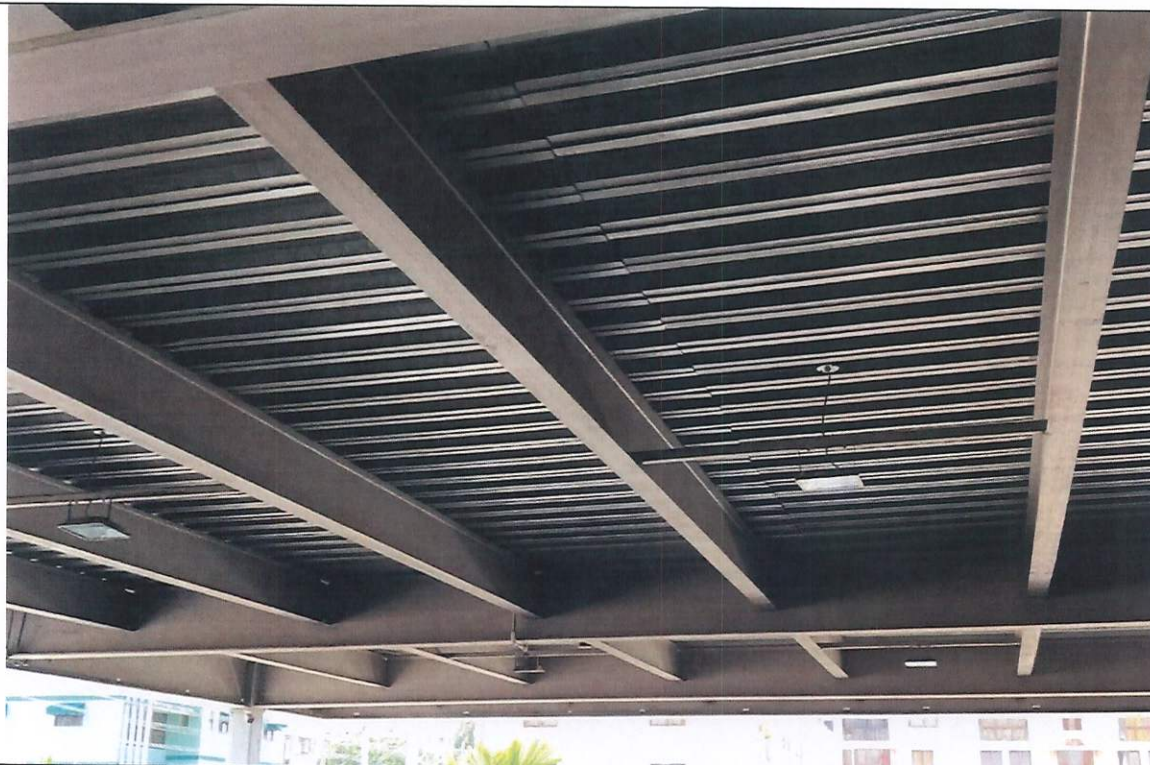
Foto 3. Sistema de Vigas del anexo en acero
