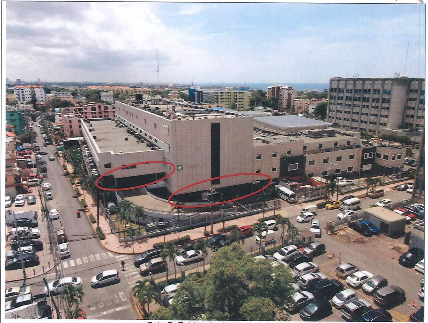
Foto 7. Evidencia de Piso Suave
