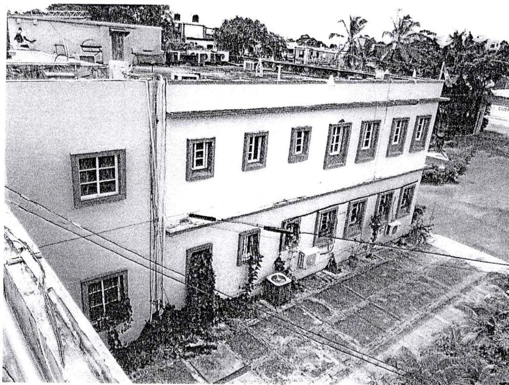
Fig. 4 Vista lateral izquierda de la edificación ONAMET1 – Bloque 1.
