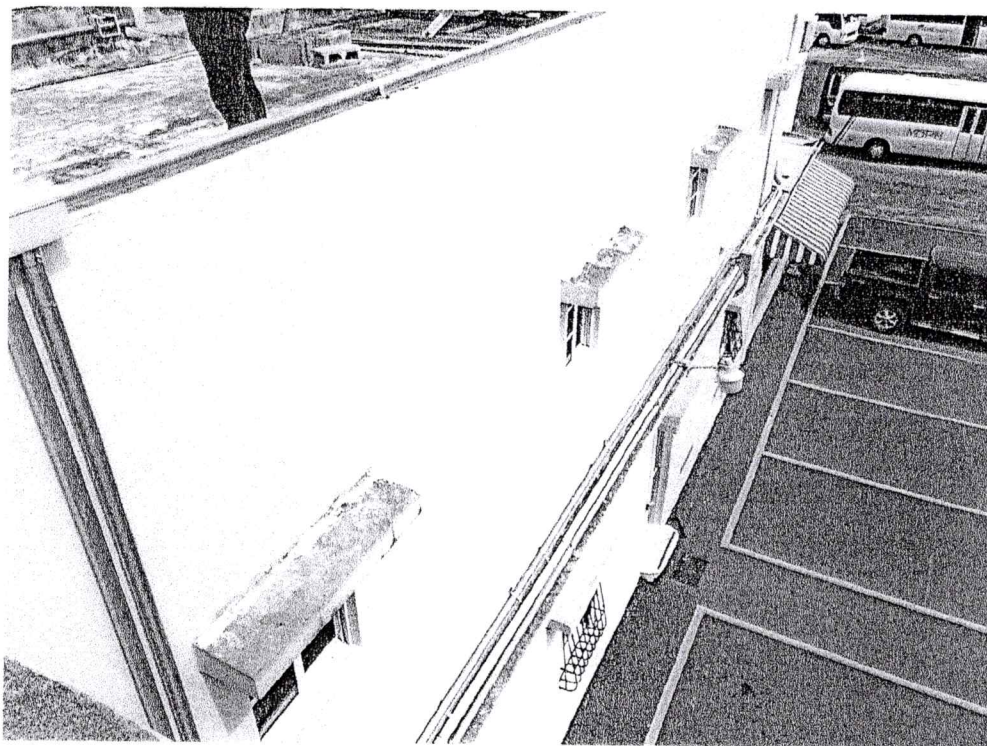
Fig. 7 Vista lateral derecha de la edificación ONAMET1 – Bloque 2 accesos a parqueos
