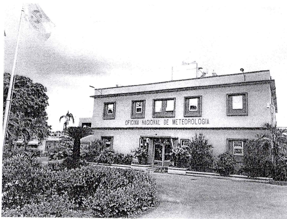
Fig. 3 Vista frontal de la edificación ONAMET1 – Bloque 1 edificación más antigua de la institución
