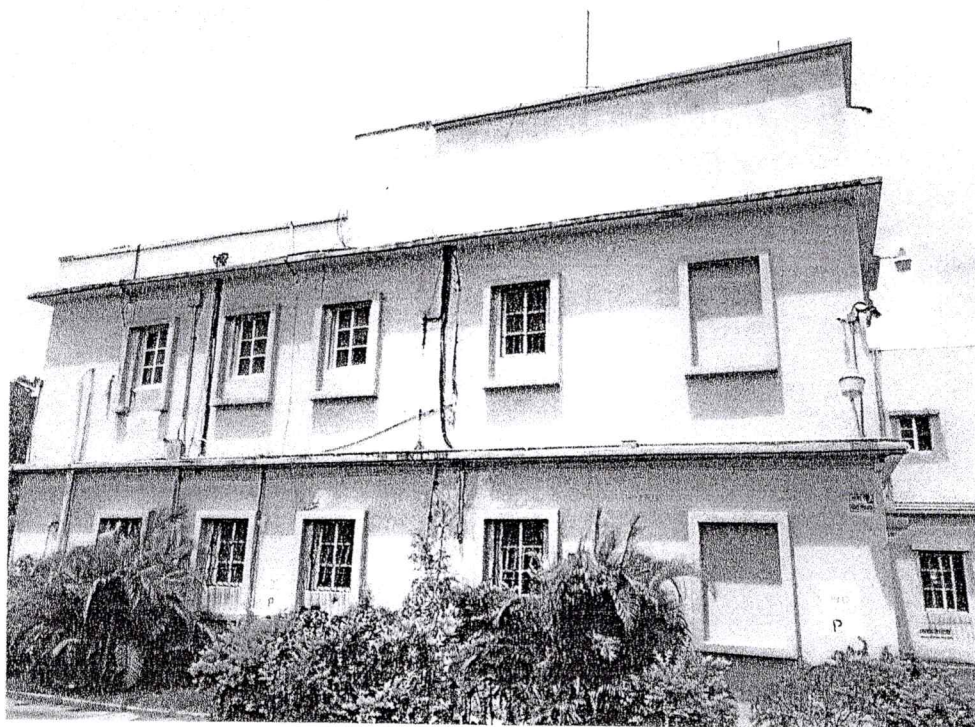
Fig. 9 Vista lateral derecha de la edificación ONAMET1 – Bloque 1
