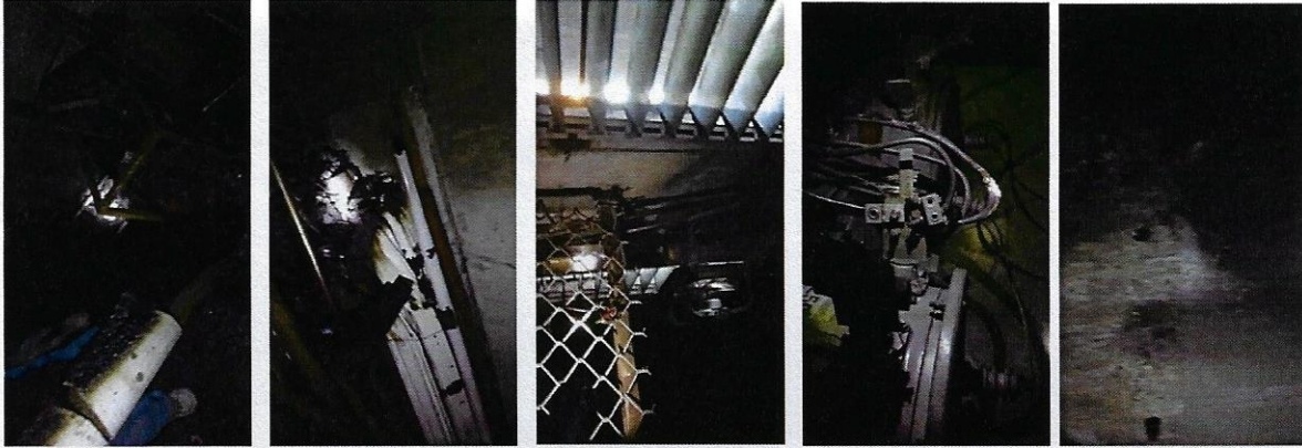
Imágenes que evidencian las condiciones de los cables eléctricos después del incendio.
