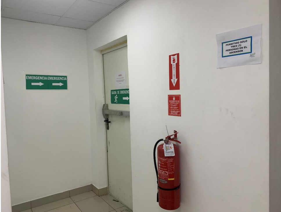
Evidencia 4: Fotos ruta de evacuación en la Institución.
