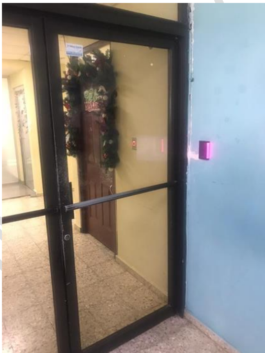
Control de acceso al pasillo del edificio 2 1er piso
