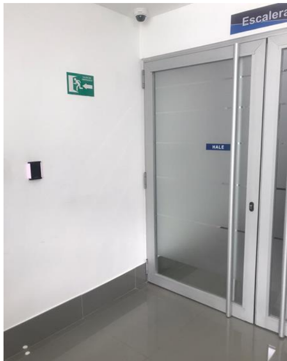
Control de acceso entrada escalera edificio 1
