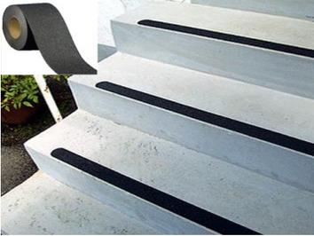
Colocar señalización de advertencia del riesgo de caída y antideslizante en las escaleras indicadas. Esta señalización se efectuará mediante franjas alternas amarillas y negras (con una inclinación aproximada de 45° y de dimensiones similares). Se recomienda que la señalización sea de material antideslizante. También se recomienda la colocación de un cartel de advertencia del desnivel, que debe colocarse
