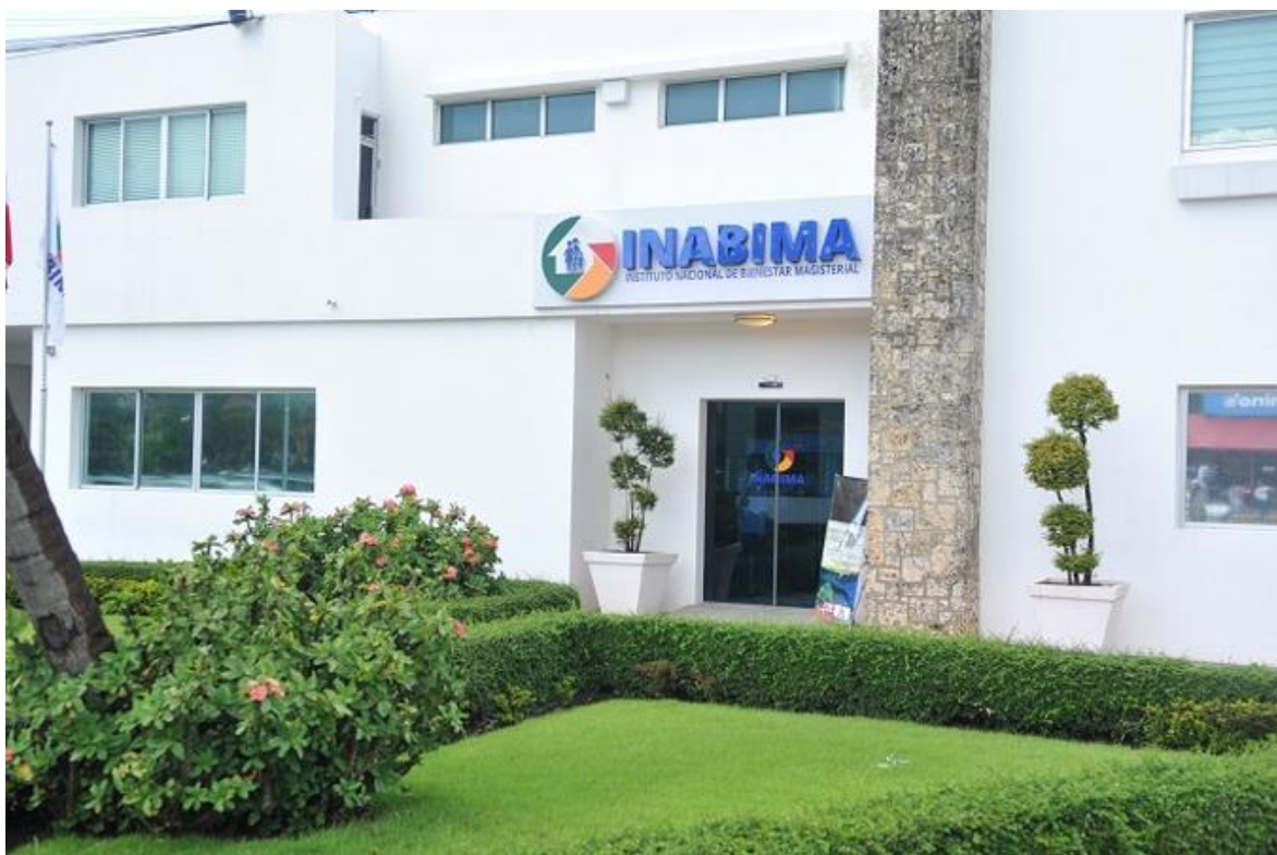
Foto: Adecuación a la infraestructura
