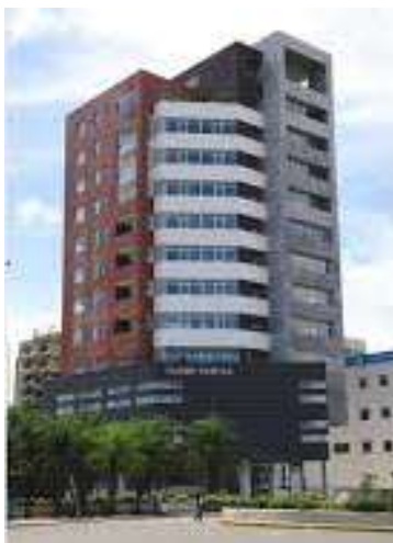
Fachada Planta de la torre Friusa
