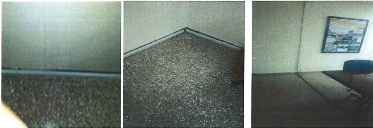
Foto No.1 Colocación de cables sueltos dentro de canaletas
