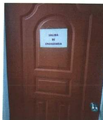
Puerta de Emergencia
