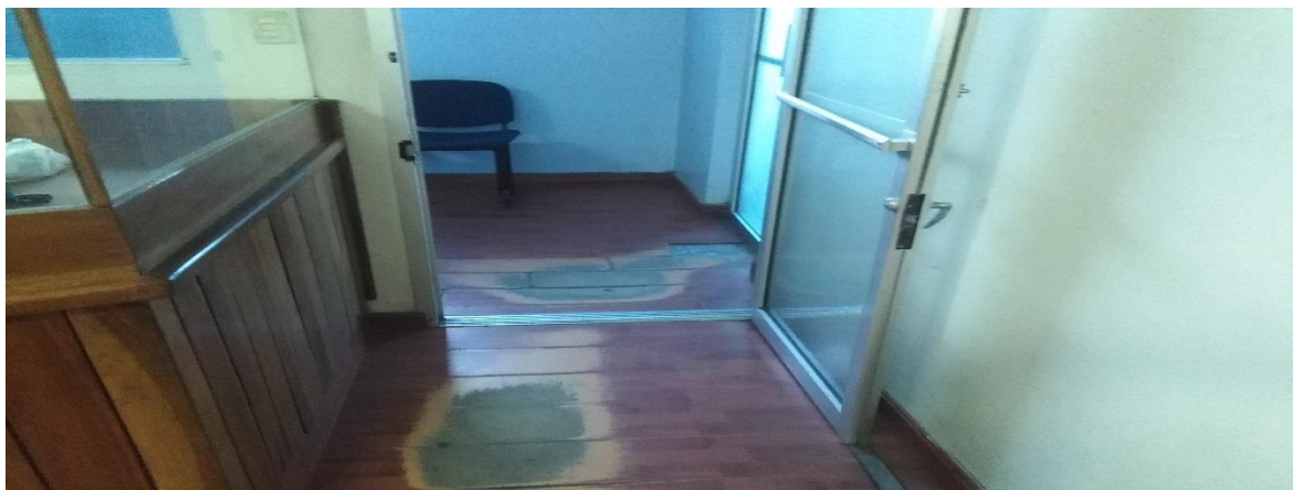
Central de Radio, pisos en mal estado.
