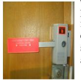
en la puerta de salida de emergencia, ubicada, por determinar esta alarma se activa inmediatamente es presionada la barra de emergencia y se abre la puerta, emitiendo un sonido que solo se desactiva en el centro de esta alarma.
