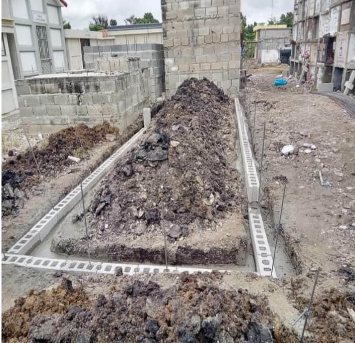
Construcción de Nichos en el Cementerio Municipal de Cayetano Germosén.
