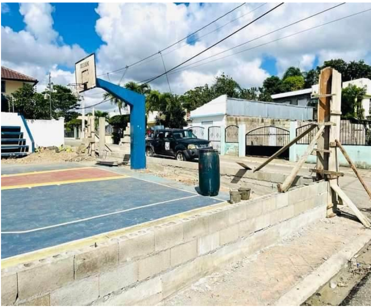
Avances de la Construcción de la Verja Perimetral de la Cancha de la Urbanización Sánchez.
