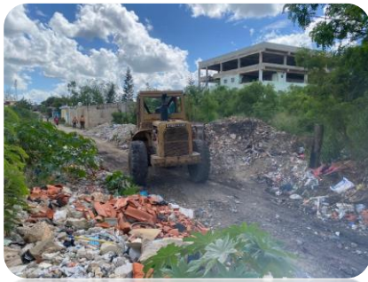
LIMPIEZA DE CALLE DETRÁS DEL HOSPITAL EL BUEN SAMARITANO.
