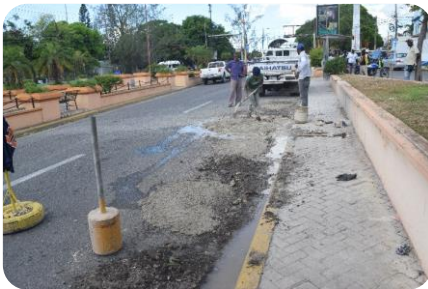
REPARACIÓN DE HOYO EN LA CALLE AV. LIBERTAD FRENTE AL OBELISCO.
