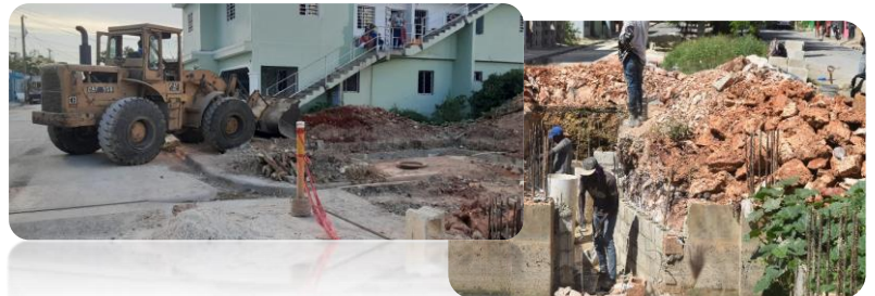
CONTINUACIÓN DE TRABAJOS EN COLECTOR PLUVIAL DE VILLA SAN CARLOS.
