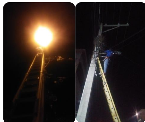
OPERATIVO DE TRABAJOS ELÉCTRICOS
