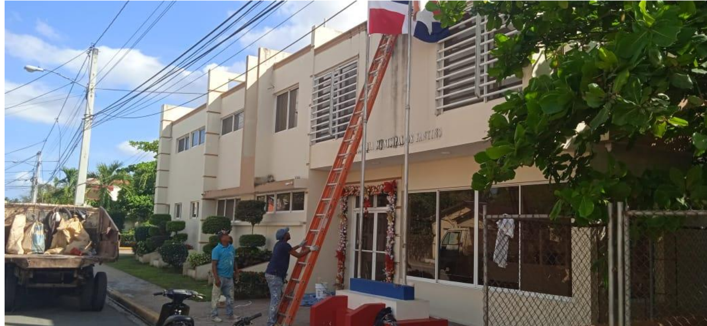
Mantenimiento al Palacio Municipal.
